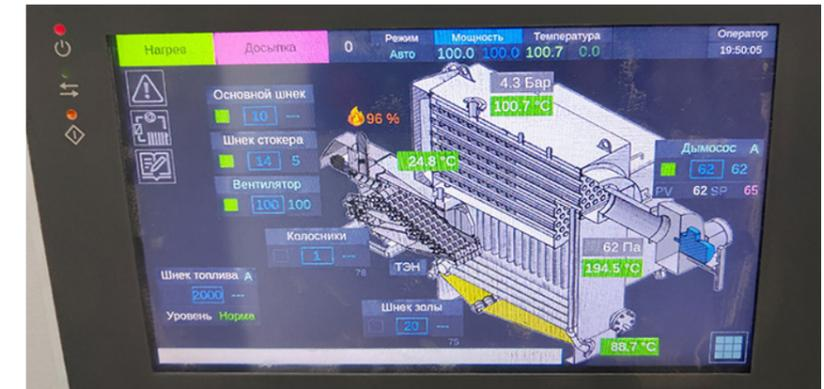
пления. А малая зольность гранул и их высокая теплотворная способность позволяют свести обслуживание котла к минимуму. Для одного агрегата достаточно проводить очистку поверхностей от зольных осадений 1 раз в 10 дней (для комплектов без автоматической очистки поверхностей нагрева).
